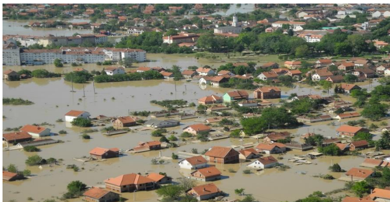
Slika 1. Poplave u Obrenovcu.
