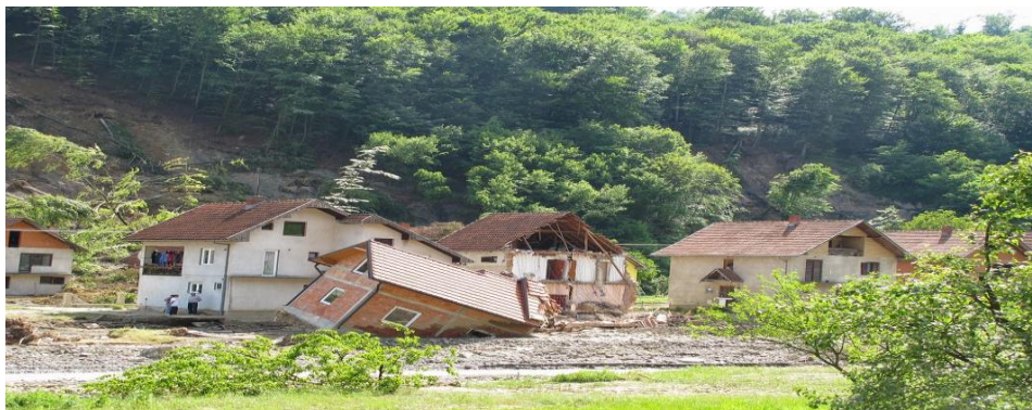
Slika 2. Klizište izazvano poplavama.
